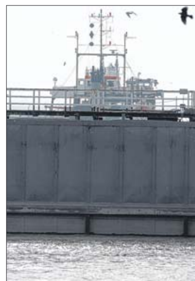
Kein Durchkommen für große Schiffe an der Schleuse Brunsbüttel.
