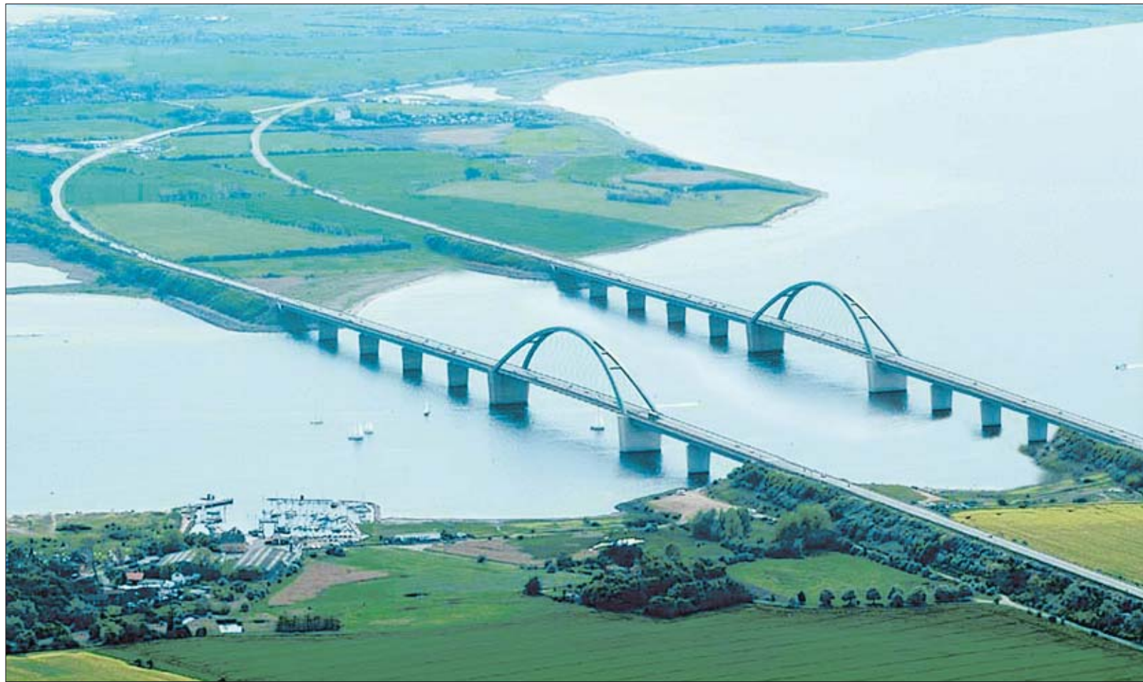
Bekommt die knapp einen Kilometer lange Fehmarnsundbrücke eine Schwester? Die LN-Montage nimmt den Anblick schon einmal vorweg.
